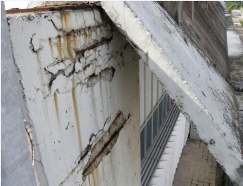
Carbonatazione con espulsione del copriferro per corrosione delle barre d'armatura.
